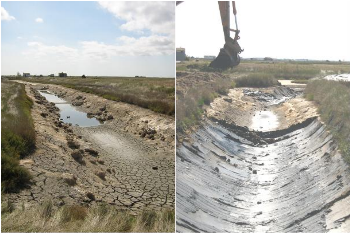
Figure 12 : Assec et curage à la pelleuse d'un fossé (F2) en août 2010 (Photos E. Buard)
