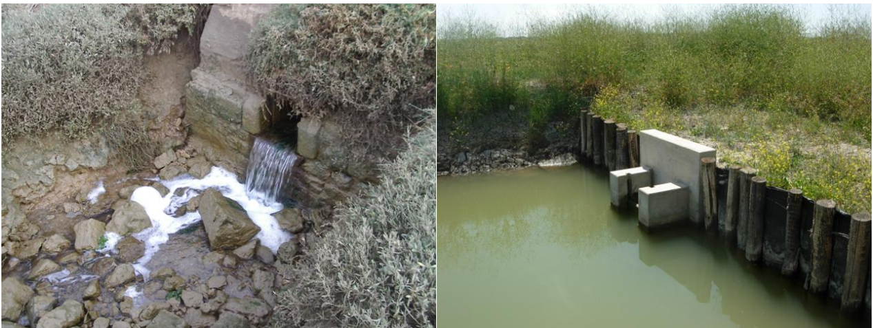
Figure 2 : Ouvrages hydraulique en pierre (à gauche) et en béton (à droite) (photos E. Buard)
